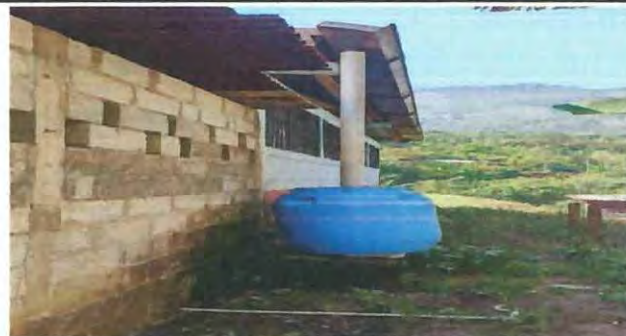
FOTO 4: CANALES Y BAJANTES DE AGUA PLUVIAL
