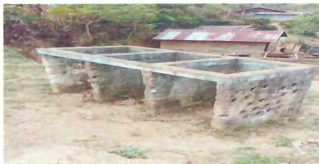
FOTO 3: MEJORAMIENTO DE INSTALACIONES DE SERVICIO SANITARIO
