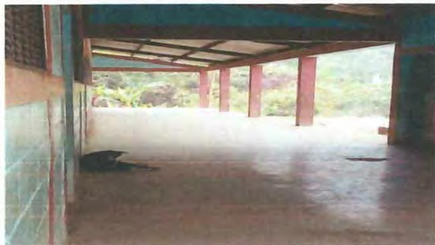
FOTO 1: MANTENIMIENTO DE PAREDES Y COLOCACION DE BARANDALES
