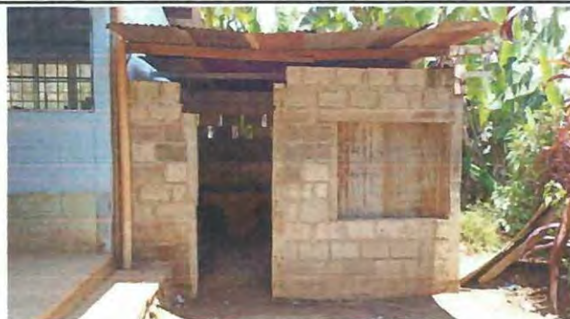
FOTO 2: MANTENIMIENTO Y SUSTITUCION EN AREAS DE COCINA Y COLOCACION DE BALCON
